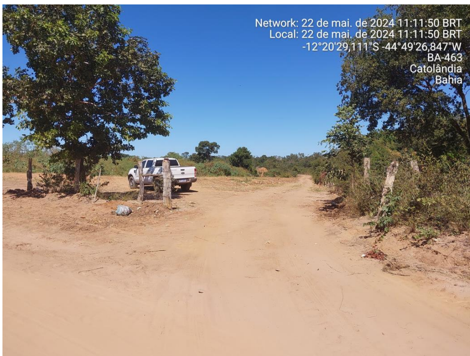
Figura 5. Porção de acesso à área de disposição de resíduos de Catolândia. Observar ausência de portão e/ou placa de advertência, bem como de qualquer ação de monitoramento.
