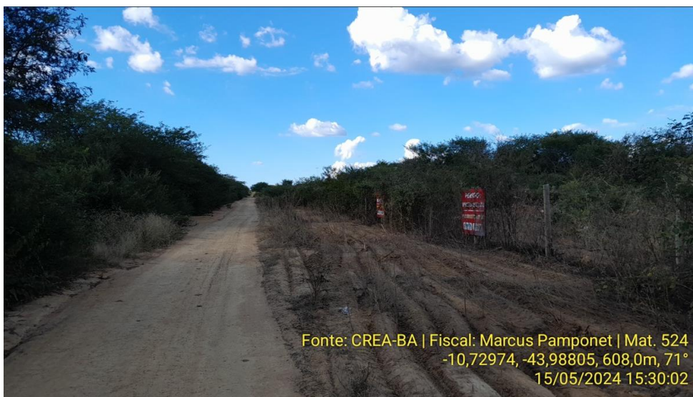
Figura 7: Condições de trafegabilidade das vias internas.
