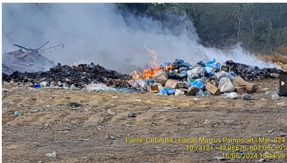
Figura 4: Evidência da prática de queima de resíduos e rejeitos a céu aberto na área nas imediações das coordenadas UTM 23 L 610965 m E; 8813523 m S datum WGS84.
