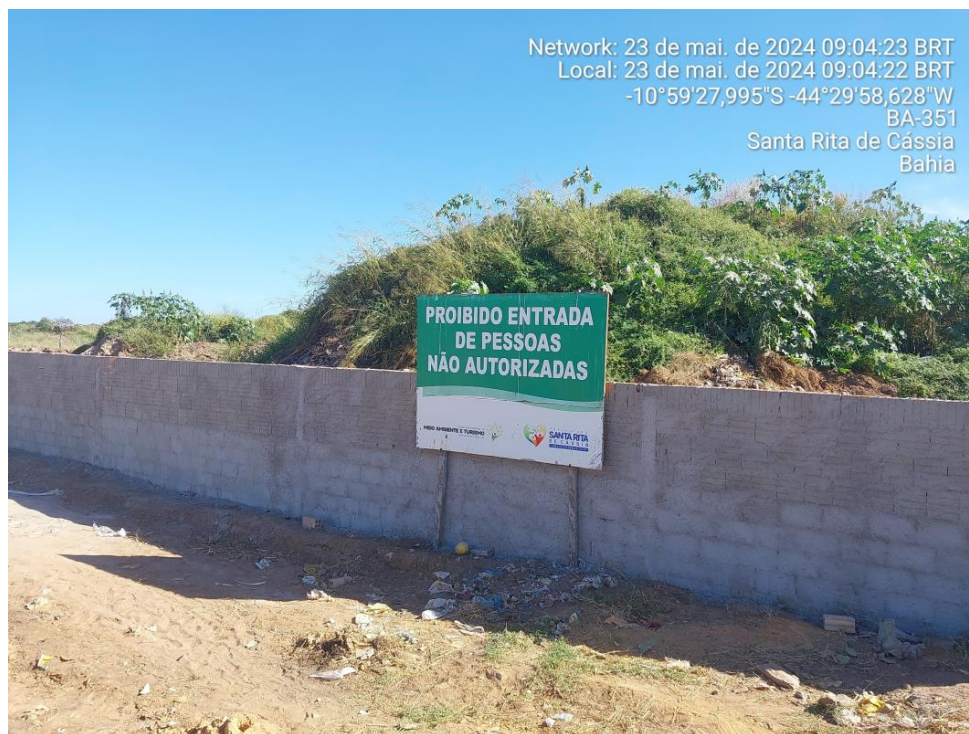
Figuras 5 a 7: Evidência da existência de medidas para impedir o trânsito de pessoas não autorizadas à área nas imediações das coordenadas UTM 23 L 554635 m E; 8784937 m S datum WGS84, utilizada para disposição de resíduos e rejeitos sólidos gerados no município de Santa Rita de Cássia/BA (muro, portão, guarita e placa indicando proibição de pessoas não autorizadas) Fonte: acervo próprio.
