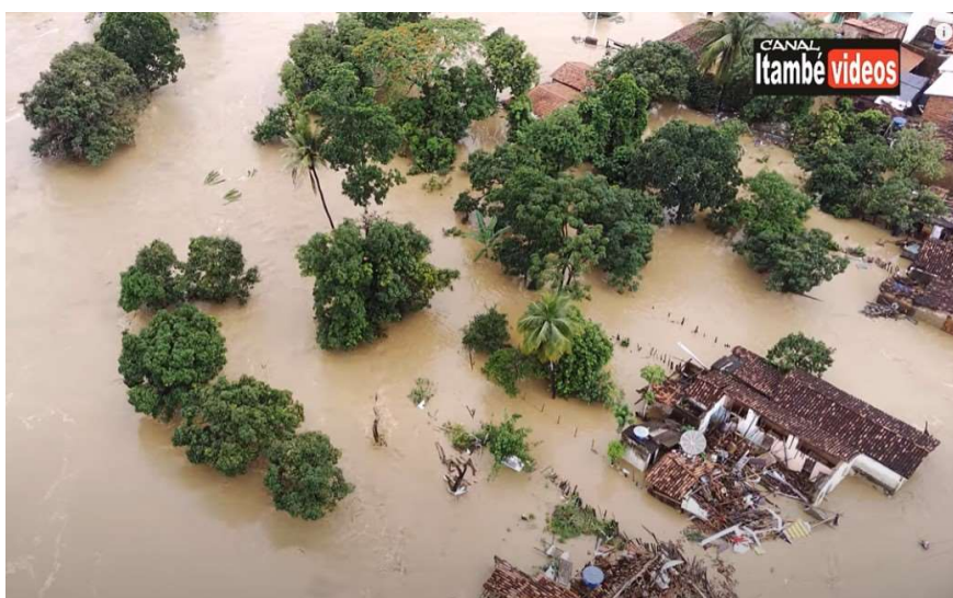
Figura 25. Edificações destruídas pela força das águas do Rio Verruga na área de inundação. Imagem extraída do vídeo “URGENTE: EM ITAMBE RIO VERRUGA TRANSBORDA E ALAGA VÁRIAS RUAS DA CIDADE”.
