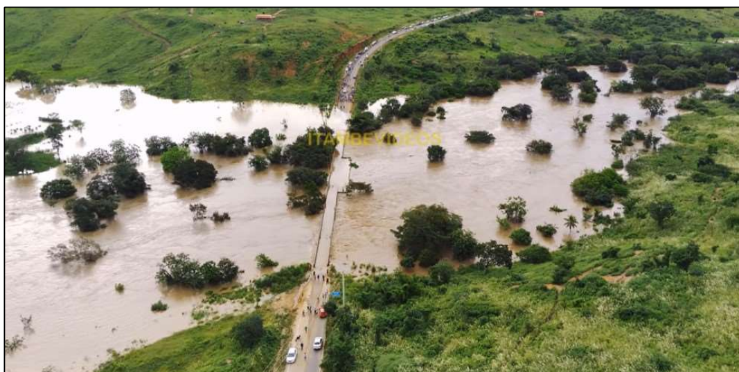
Figura 05. Trecho do Rio Pardo em 29 de dezembro de 2021, conforme vídeo "PERIGO: RIO PARDO PASSA SOBRE A PONTE QUE LIGA ITAMBE A RIBEIRÃO DO LARGO." Notar que o fluxo d'água extravasou o leito regular do curso d'água para as Áreas de Preservação Permanente - APP referente a suas faixas marginais.
