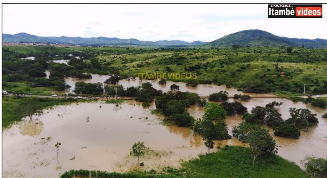
Figura 06. Trecho do Rio Pardo em 29 de dezembro de 2021, conforme vídeo “PERIGO: RIO PARDO PASSA SOBRE A PONTE QUE LIGA ITAMBE A RIBEIRÃO DO LARGO.” Notar que o fluxo d’água extravasou o leito regular do curso d’água para as Áreas de Preservação Permanente - APP referente a suas faixas marginais.
